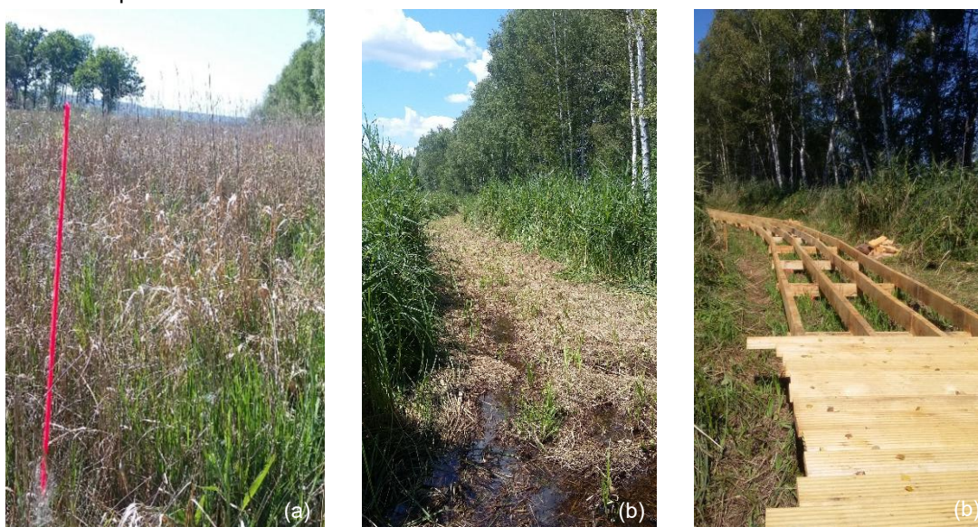
Figure n° 20 : Avant (a) et après (b) du fauchage et platelage du futur chemin pédagogique débuté en juillet © E. GAROT (2025)
