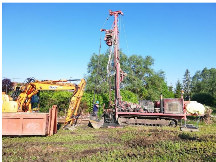
Figure 6 - Travaux de forage aux abords de la tourbière de Vred pour pouvoir installer par la suite un couple de piézomètres profonds dans le cadre des études éco-hydrologiques © M. Castelli
